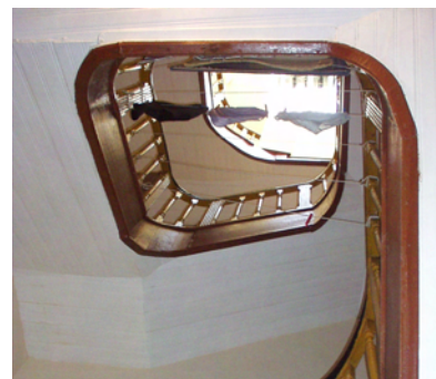
Fig. 29_ Acesso Vertical (P43)
