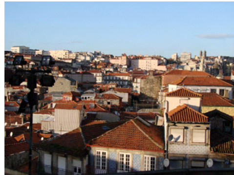
Fig 58-Vista actual do interior do quarteirão
